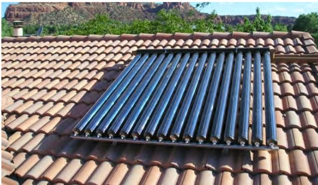
Abb. 188: Solaranlage am Dach eines Einfamilienhauses; freshideen.com
